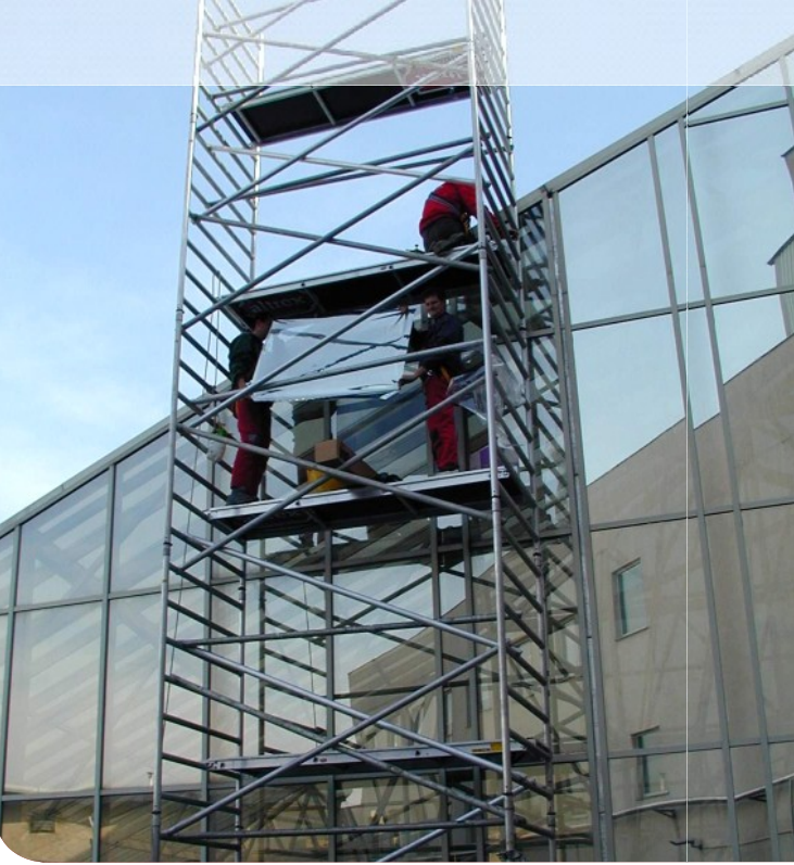
▲ Przykład instalacji folii zewnętrznej
