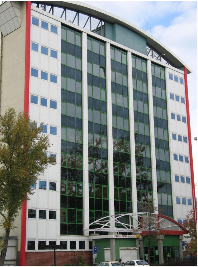
▲ Budynek po instalacji folii RE35NEARXL – folia w minimalny sposób wpływa na wygląd elewacji
