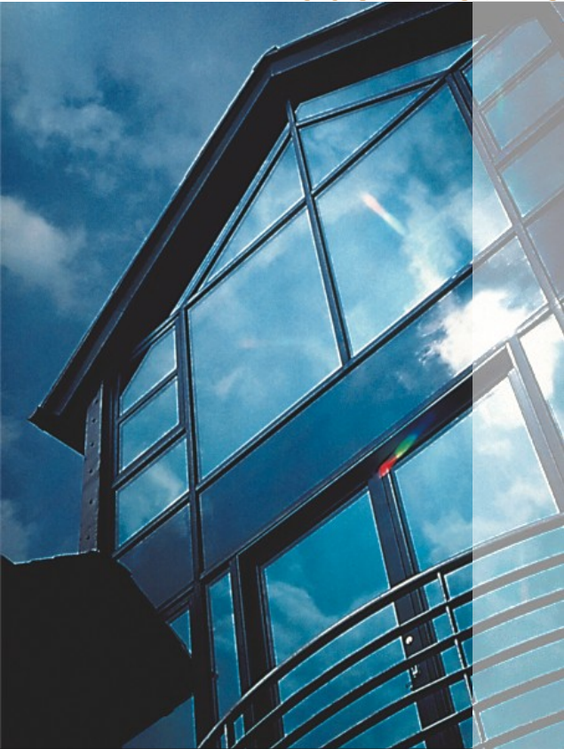
▲ Budynek po instalacji folii RE35NEARXL – folia w minimalny sposób wpływa na wygląd elewacji
